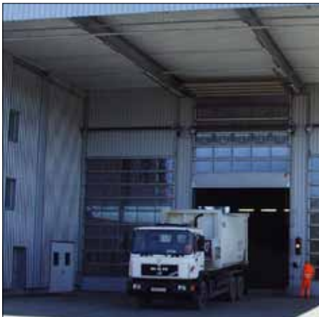
Abb. 28: Anlieferung von Restabfall an der MBS-Anlage
