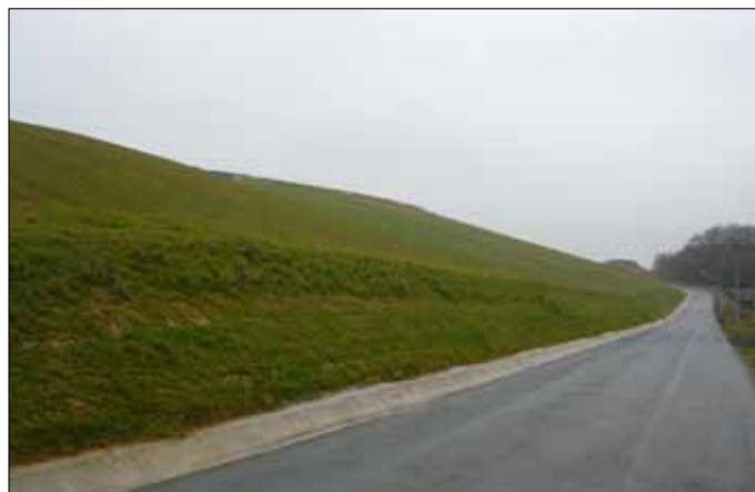
Abb. 33: Fortschritt der Arbeiten an der Oberflächenabdeckung im Deponieabschnitt B3, Stand Dezember 2013
