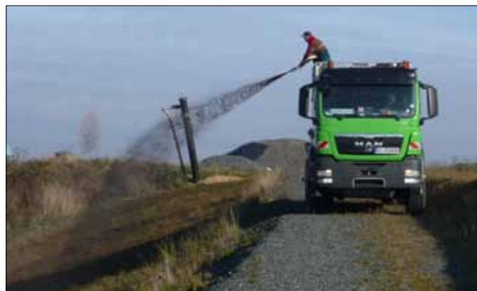
Abb. 34: Spezialfahrzeug zum Aufbringen der Saatenmischung im Anspritzverfahren.
