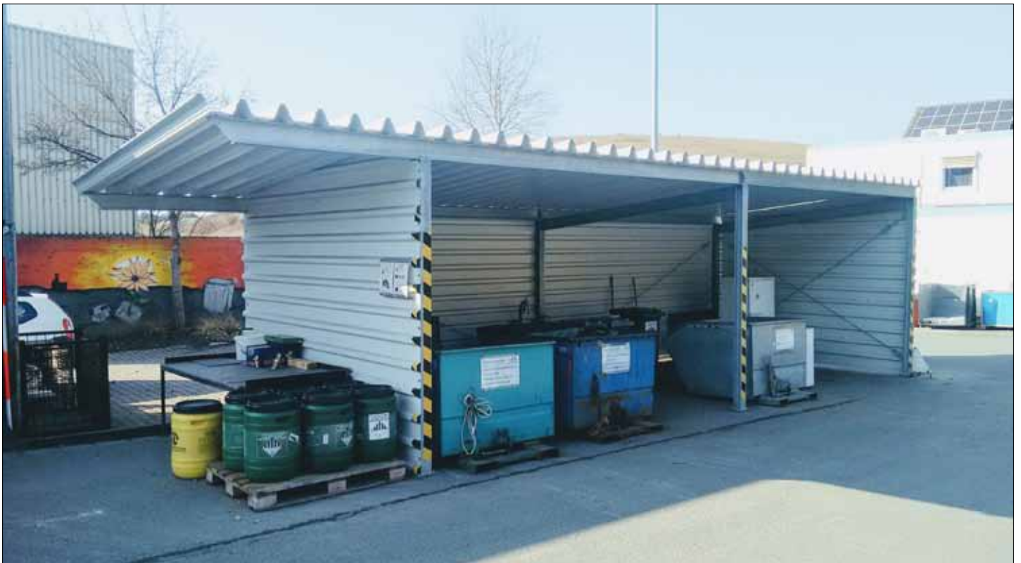
Abb. 39 Überdachte Anlieferzone für ausrangierte Elektronik- und Elektrogeräte sowie Batterien und Akkus
