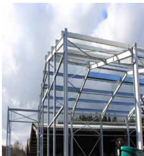
Abb. 25: Stahlkonstruktion der neuen Halle
