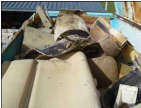
Abb. 55: Container mit gereinigten und zerkleinerten Heizöltanks.
