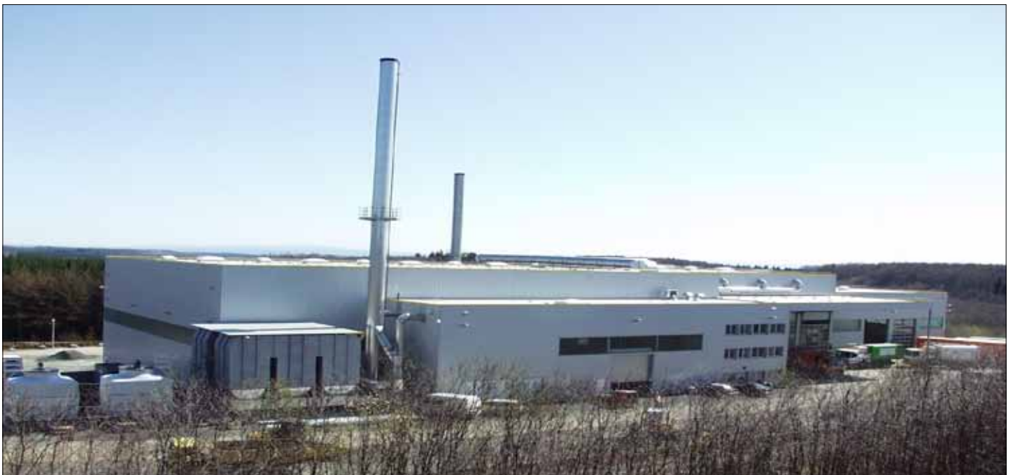
Abb. 31: MBS-Anlage zur Restabfallbehandlung in Rennerod
