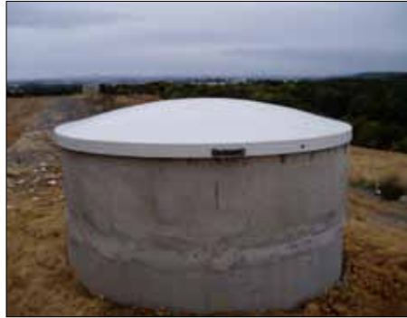
Abb. 14: Betonschachtring zum Schutz des Brunnenkopfes
