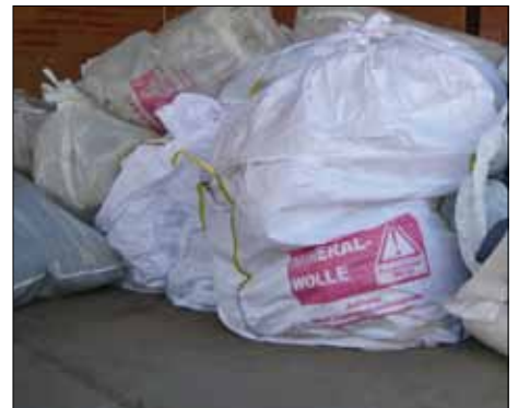
Abb. 62: Mineralfaserabfall wird staubdicht in zugelassenen Gewebesäcken verpackt angenommen.
