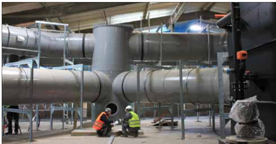
Abb. 18: Teil der neuen Abluftreinigung im Kompostwerk in Beselich-Obertiefenbach
