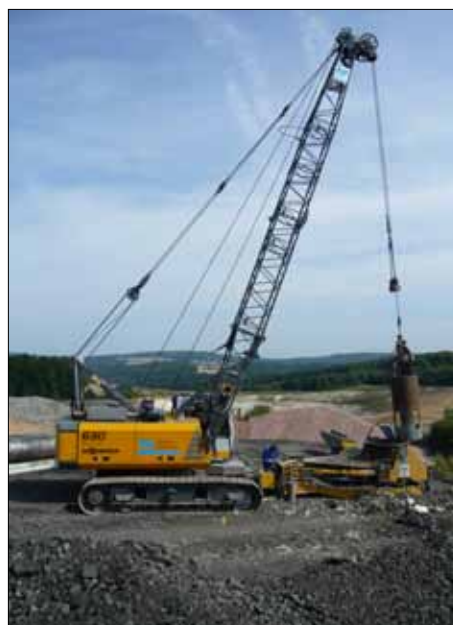
Abb. 10: Spezialbagger beim Niederbringen eines Gasbrunnens
