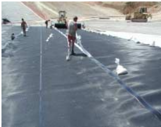
Die Basisabdichtung besteht aus mehreren Tonschichten mit zusätzlicher Kunststoffdichtungsbahn
