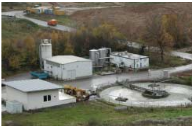
Sickerwasser wird durch eine deponieeigene Kläranlage gereinigt
