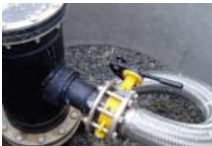
sowie oberer Abdichtung mit Gas-Transportleitung
