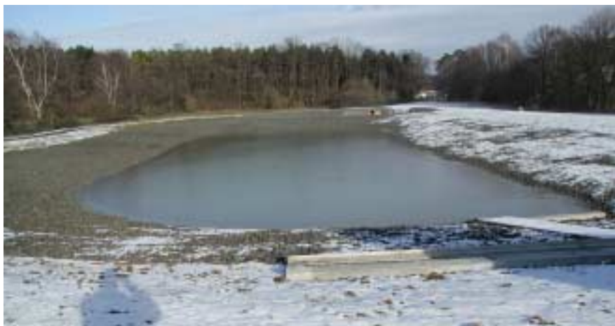
Zur Rückhaltung des anfallenden Regenwassers, sowie als weitere Löschwasserreserve dient der Polder
