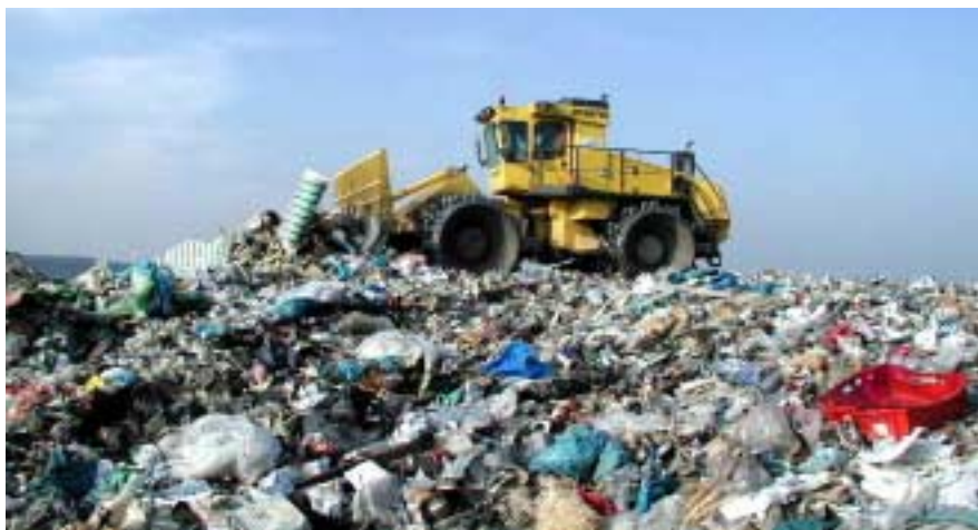
Für den Abfalleinbau werden moderne Verdichter eingesetzt.
