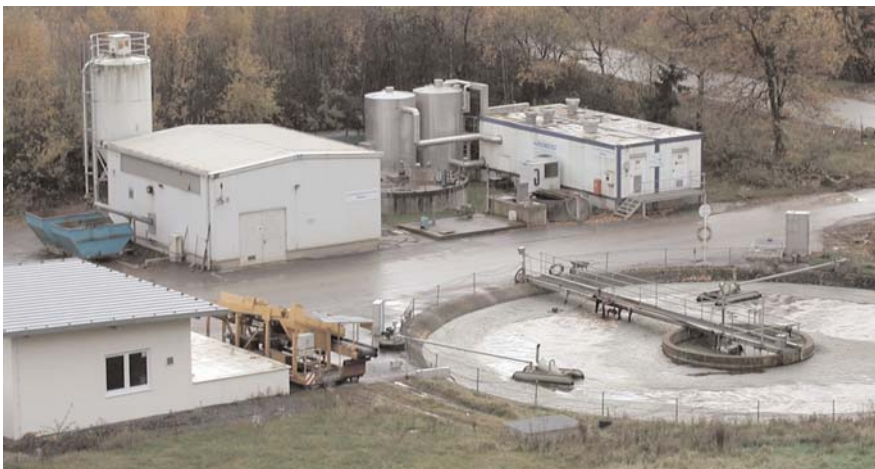
Das Sickerwasser wird durch eine deponieeigene Kläranlage gereinigt
