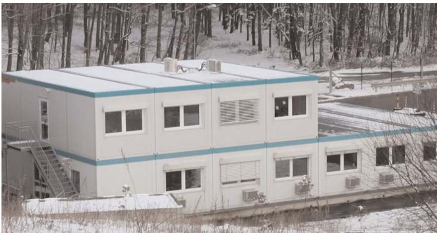
Im oberen Stockwerk wurden die Büros für die Gebührenveranlagung geschaffen
