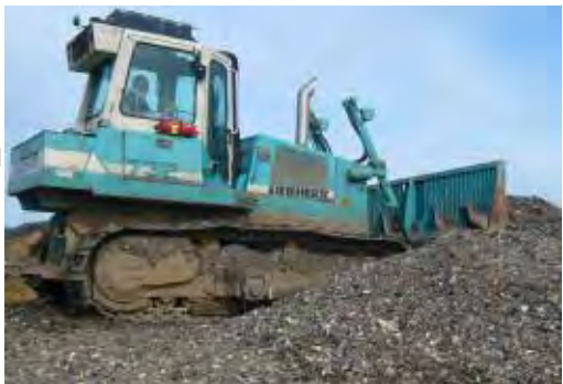
Einbau des vorbehandelten Abfalls
