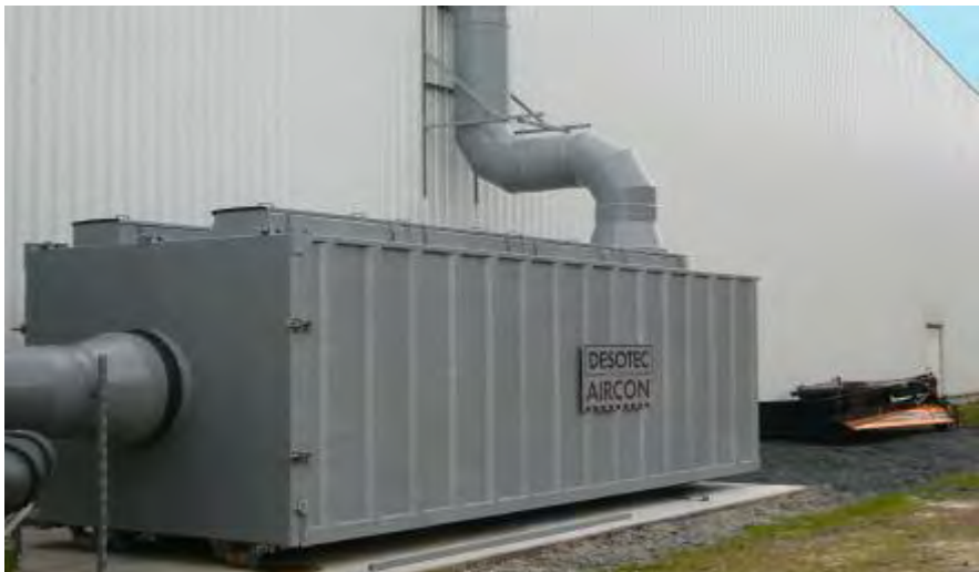
Aktivkohlefilter zur Abluftreinigung
