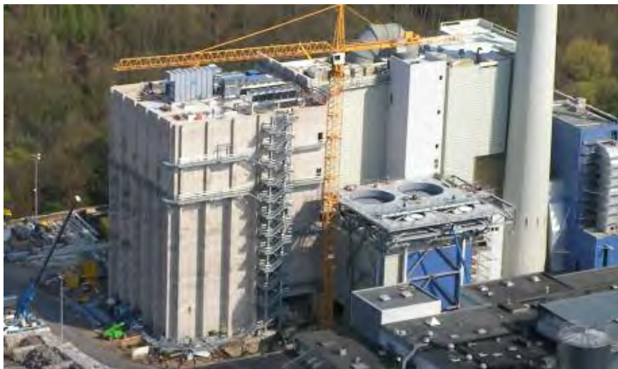
Kraftwerk für Ersatzbrennstoff in Witzenhausen kurz vor der Fertigstellung
