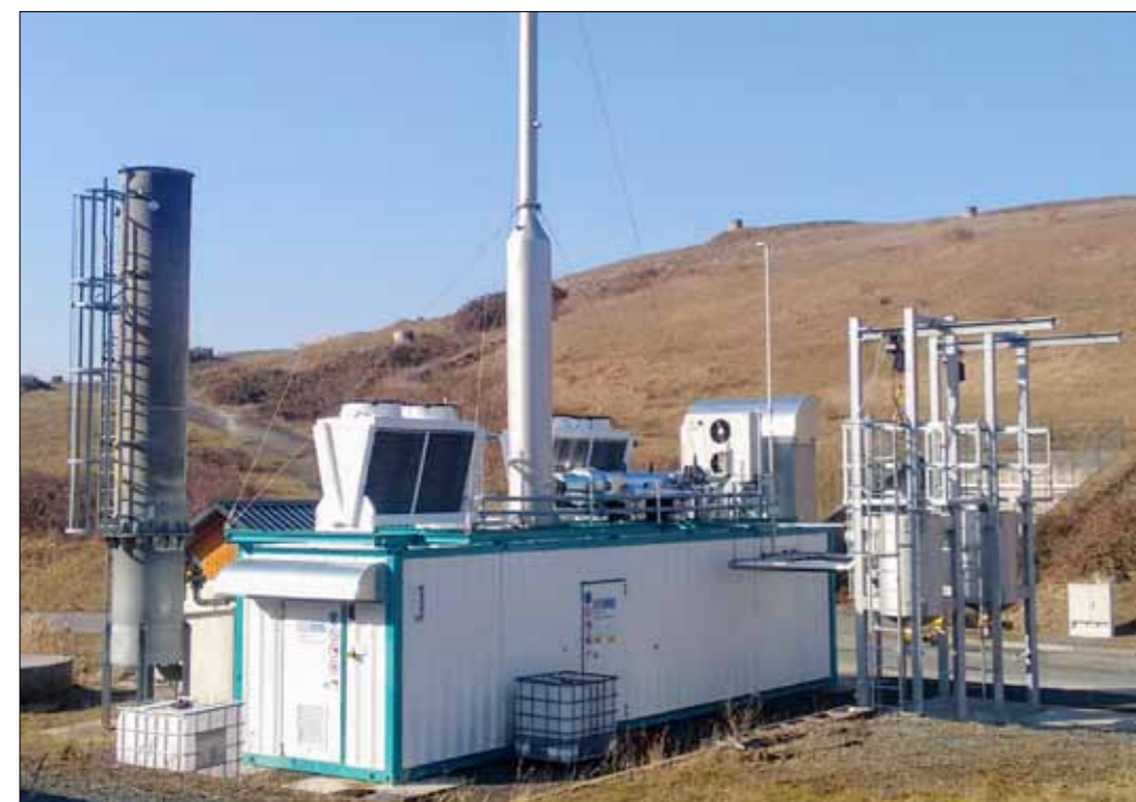
Abb. 2: Blockheizkraftwerk (BHKW)
