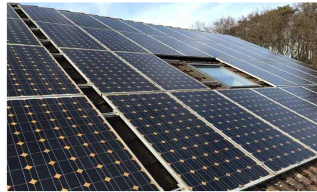
Abb. 2: PV-Anlage auf dem Dach des Betriebsgebäudes des AWB
