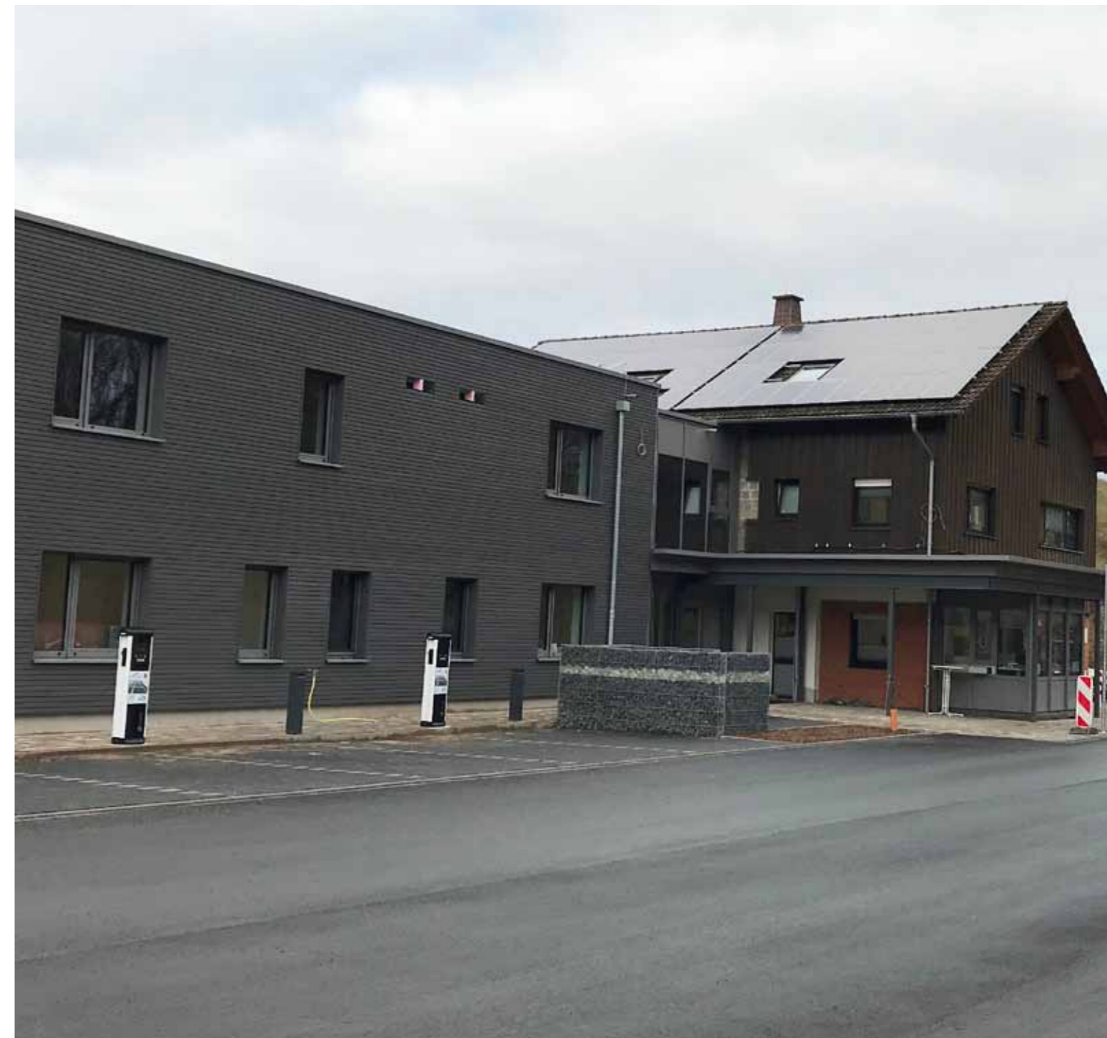
Neues Verwaltungsgebäude des AWB errichtet als Passivhaus, Parkplatz mit zwei Ladesäulen für Elektrofahrzeuge
